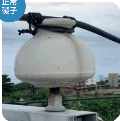
礙子上附著大量鹽塵，導致電力設備故障
